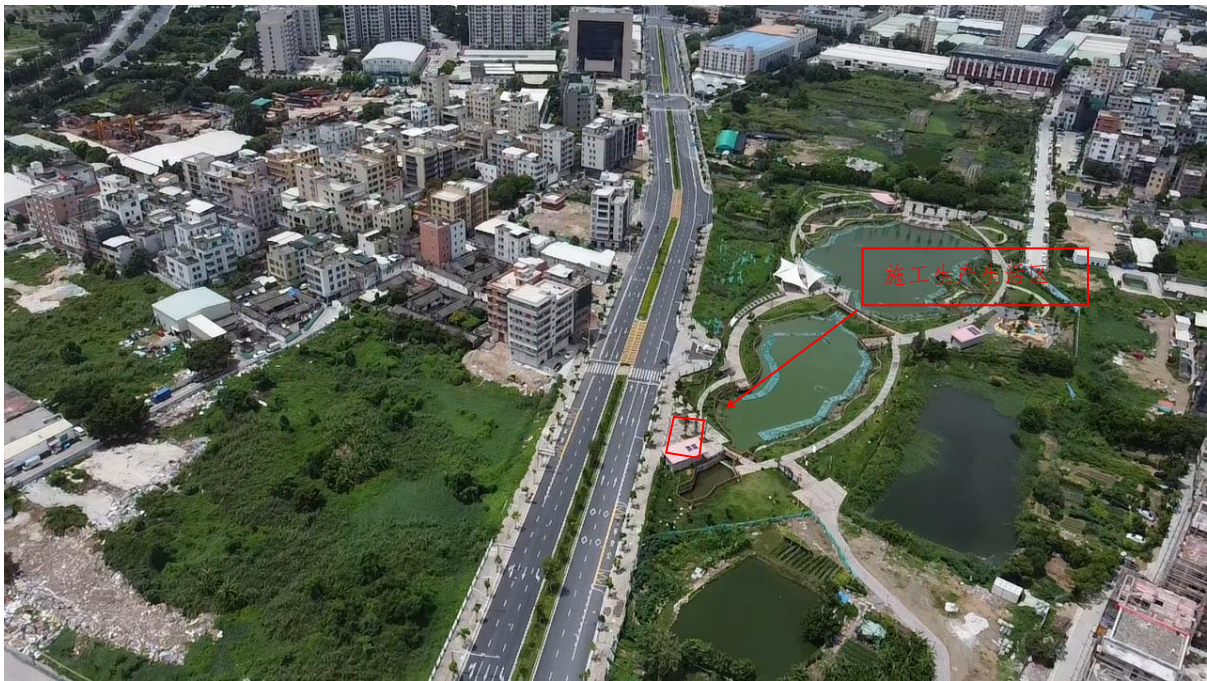
图 1-2 施工生产生活区现状
