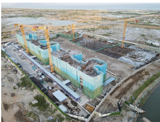
照片 2.1-1 工程航拍现状
