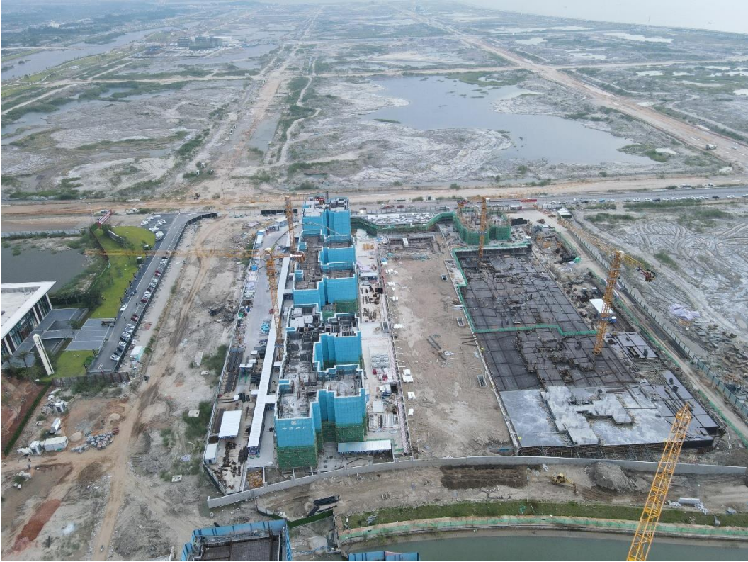
照片 1 项目西北侧现状
