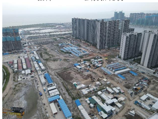
照片 2.1-4 共用的施工营造区现状
