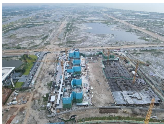
照片 2.1-2 工程航拍现状
