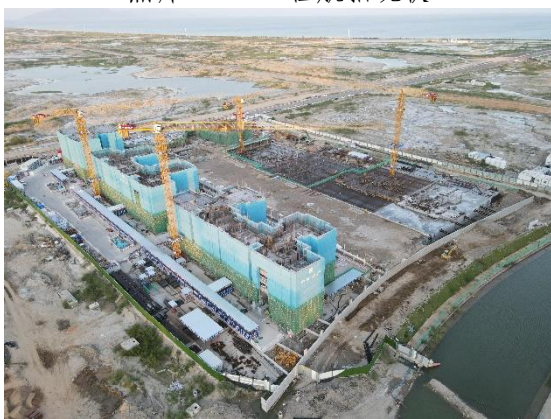
照片 2.1-3 工程航拍现状
