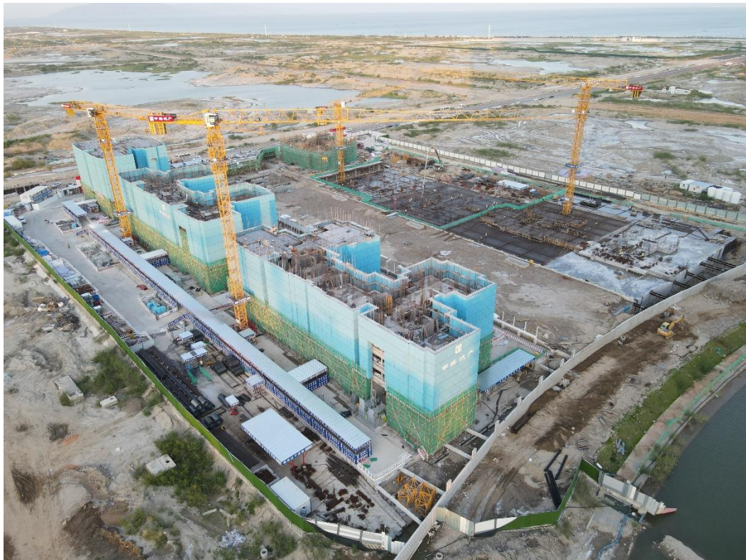
照片 2 项目南侧现状
