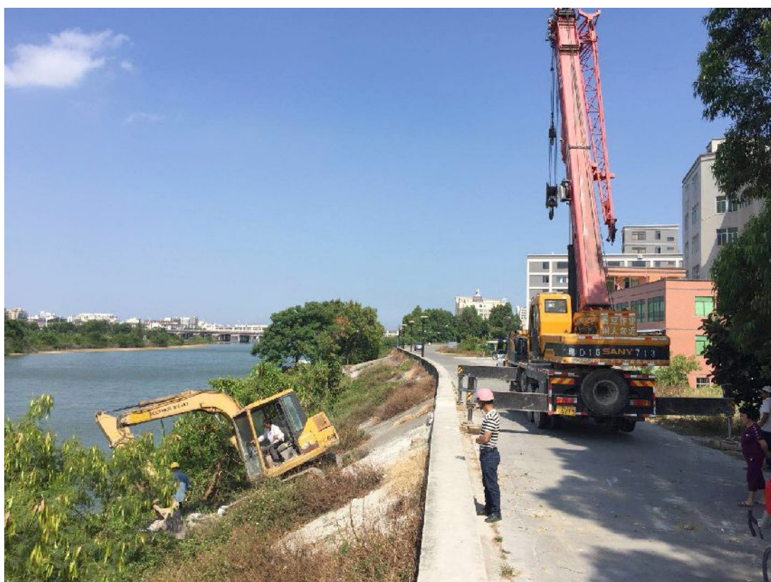
小码头整治进行中照片二
