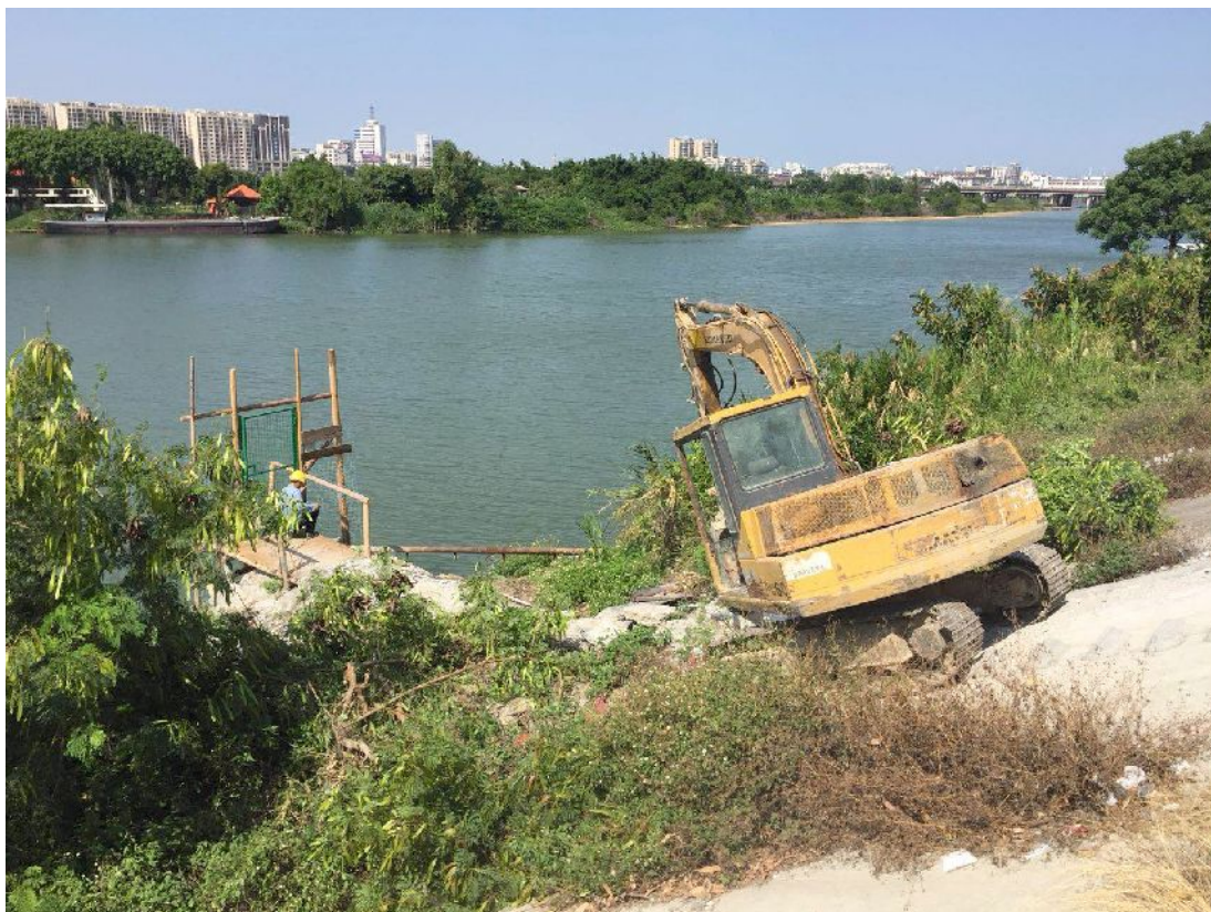
小码头整治进行中照片一
