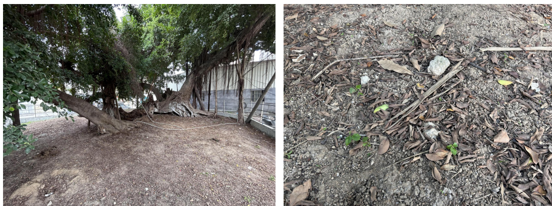
图 13~14 生长环境一般，树池内土壤含建筑垃圾及生活垃圾
