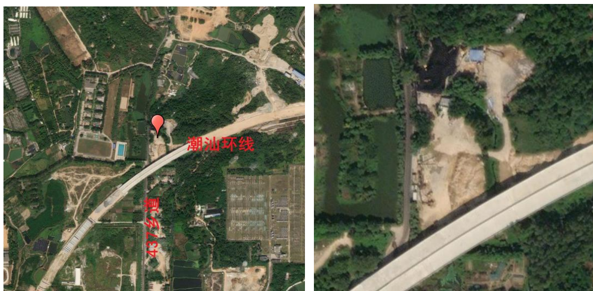
图 7-2 汕头市建筑废物资源化综合利用 BOT 项目场址情况
