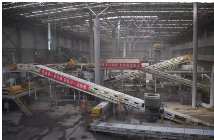
图 3-3 北京市核心区及朝阳区装修垃圾收运处一体化示范项目现场
