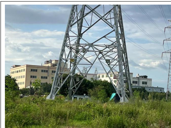
7、C4 塔基现状 2023 年 8 月
