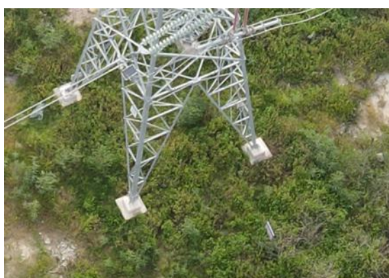
10、A5 塔基现状 2023 年 8 月
