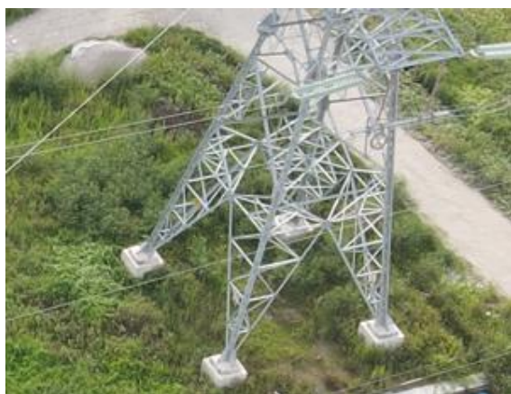
8、C4 塔基现状 2023 年 8 月
