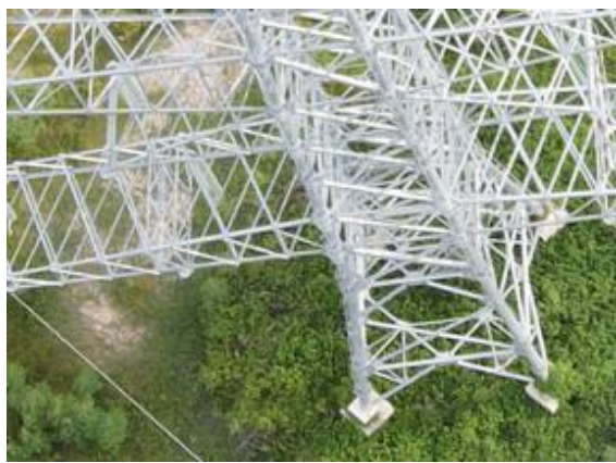
12、A4 塔基现状 2023 年 8 月
