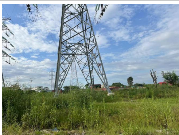
9、A5 塔基现状 2023 年 8 月
