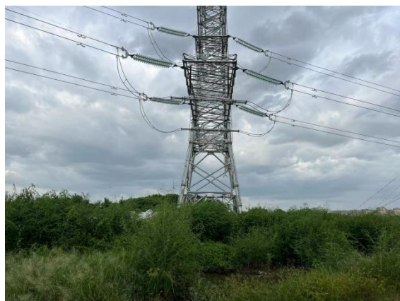
11、A4 塔基现状 2023 年 8 月
