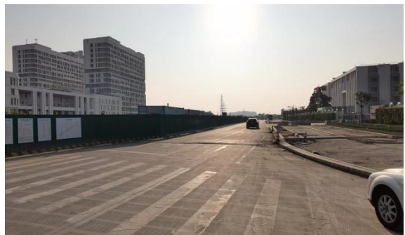
照片8：道路设计终点东侧龙江路现状
