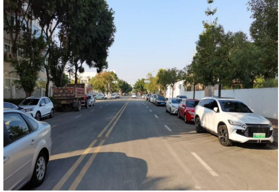
照片2：珠峰路完成建设部分断头路现状
