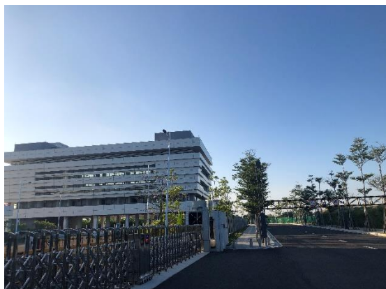
照片 4 新建综合训练馆（副馆）
