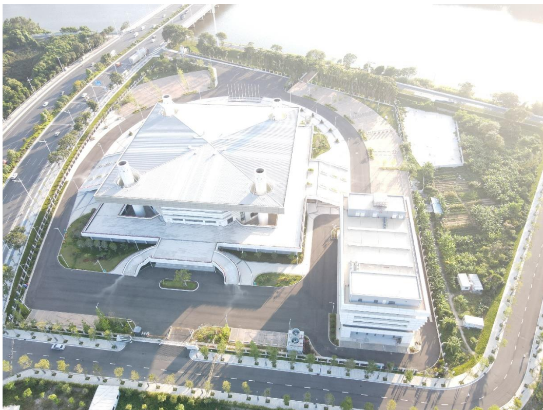
照片 1 项目区航拍图 1
