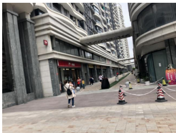
照片 2 区内建筑物 2
