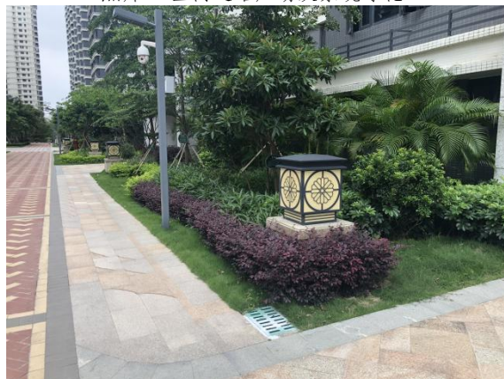
照片 6 路侧雨水口 2
