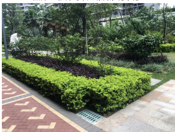
照片 5 路侧雨水口 1
