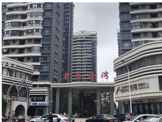
照片 1 区内建筑物 1
