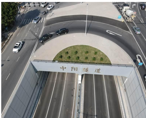
中阳隧道现状 (2022.2)
