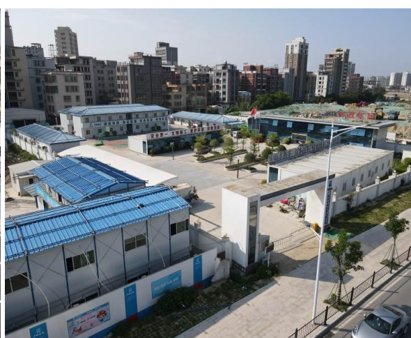
施工临建区现状 (2022.2)
