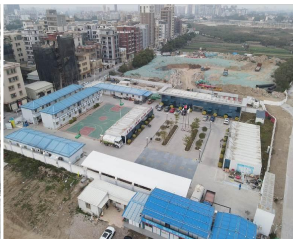
施工临建区现状 (2021.11)
