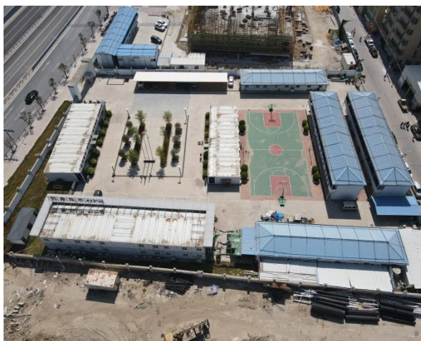
施工临建区现状 (2022.8)
