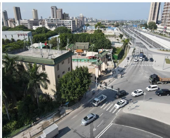
C、D隧道现状 (2022.2)
