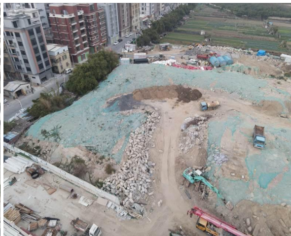
主线路段桩号 K0+700~设计终点现状(2021.11)
