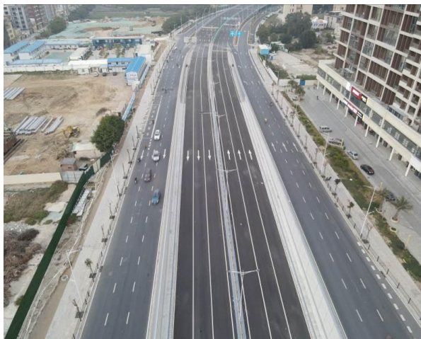
主线路段桩号 K0+700~设计终点现状(2021.11)
