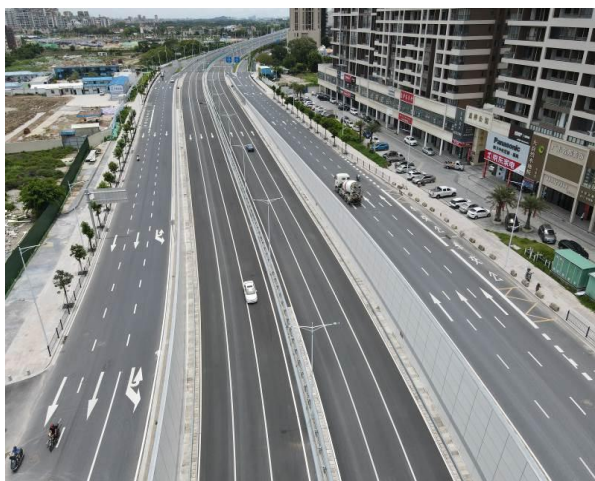
主线路段桩号 K0+700~设计终点现状 (2022.4)
